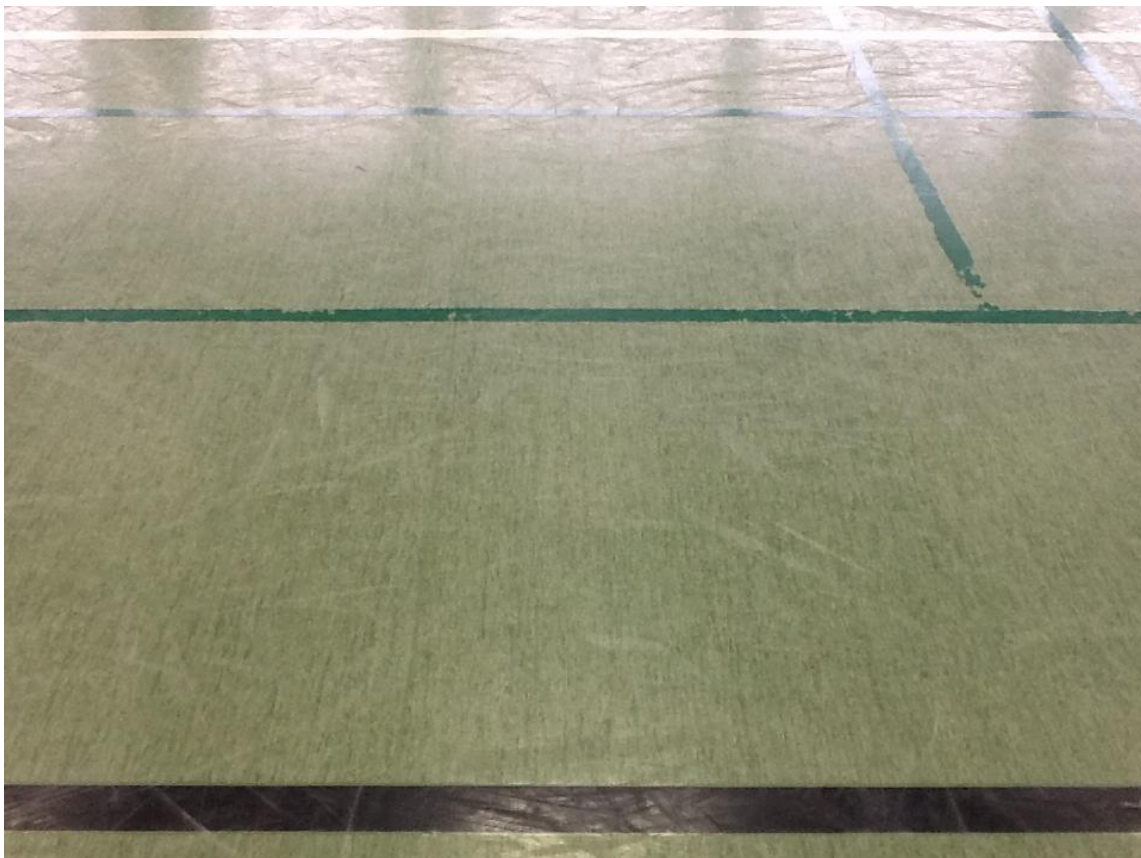
Abbildung: Turnhallenboden, das Licht blendet
